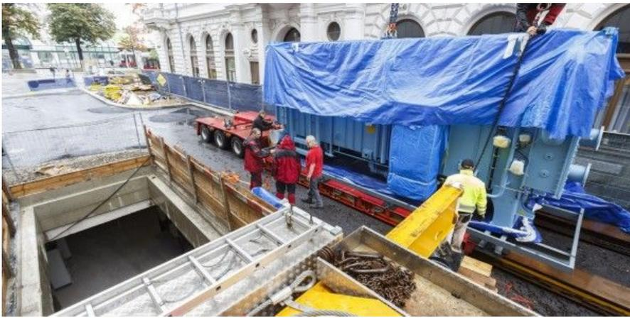
Abbildung 6.17: Bau der Fernkältezentrale am Schottenring
