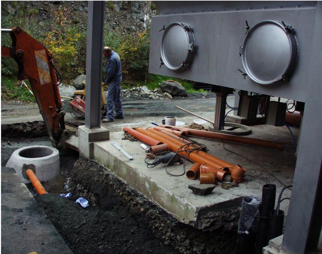
Abb. 7: Fertigstellung des Deponiegasanschlusses für die LARA Aßlar
