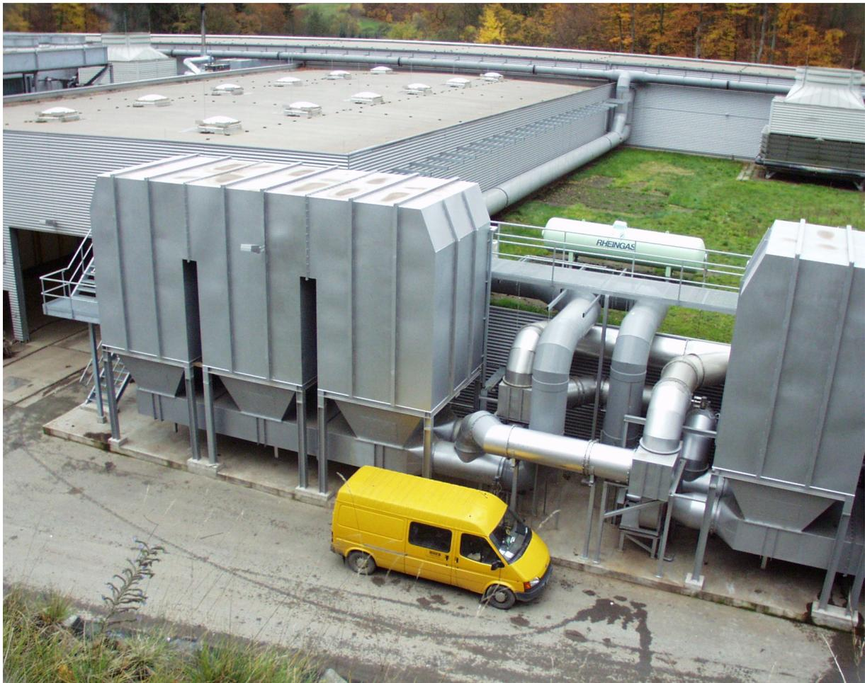
Abb. 6: Abgasbehandlungsanlage an der MBA Aßlar (im Betrieb).
